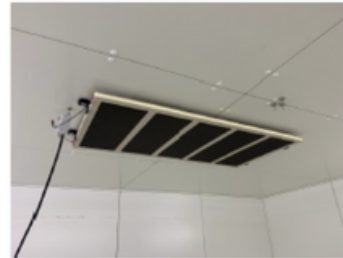
Abbildung 2: Montage des Heizgerätes an der Decke
